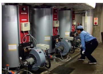
ボイラー定期点検
