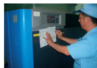
コンプレッサー定期点検
