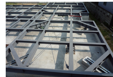
羽根田様邸基礎工事
