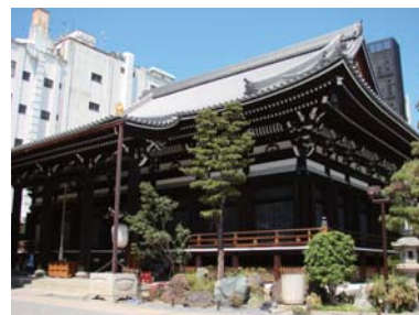
本願寺全景 床下と屋根裏に制震装置、本堂内須弥壇に免震装置を採用
