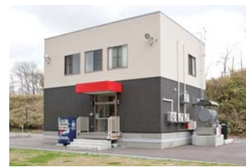
太陽光パネル、雨水タンク、BCP 備蓄品、サーバを設置してある免震棟
