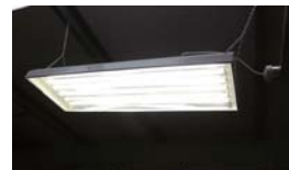
省エネ蛍光灯
