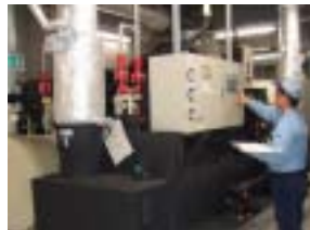
A重油焚き吸収式冷温水機をターボ冷凍機に更新し、エネルギー消費量を削減。
