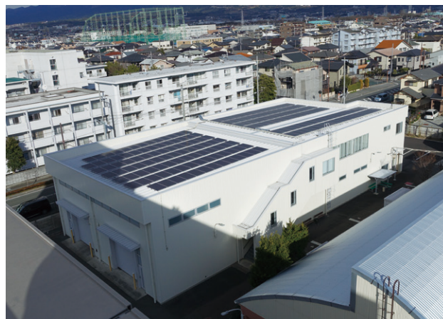
開発棟に設置された太陽光パネル
