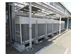
空調設備更新（甲府工場）
