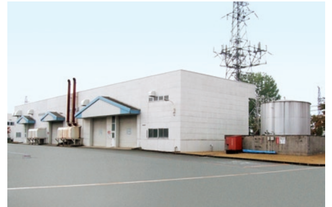
山形工場の自家発電装置棟
