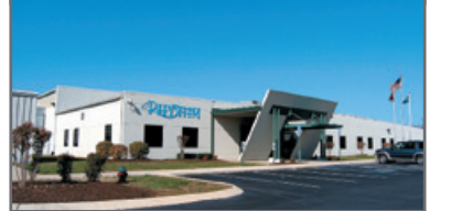
SAMICK THK CO., LTD. HEADQUARTERS AND DAEGU PLANT 【韓国】
